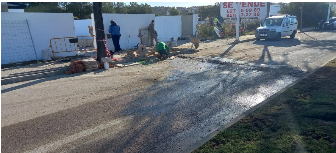
C/ Juan Pablo II: Obra realizada por la empresa Guillecar
