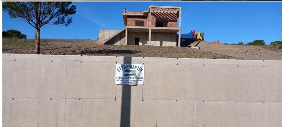
C/ Rosalía de Castro: Obras realizada por Ferramartin
