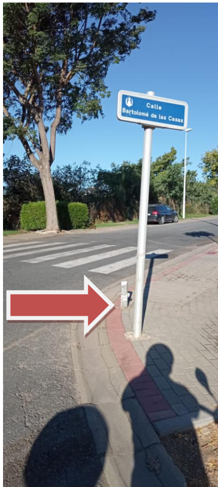
6.- Bartolomé de las Casas. Poste de señala cortada con peligro para caídas.
