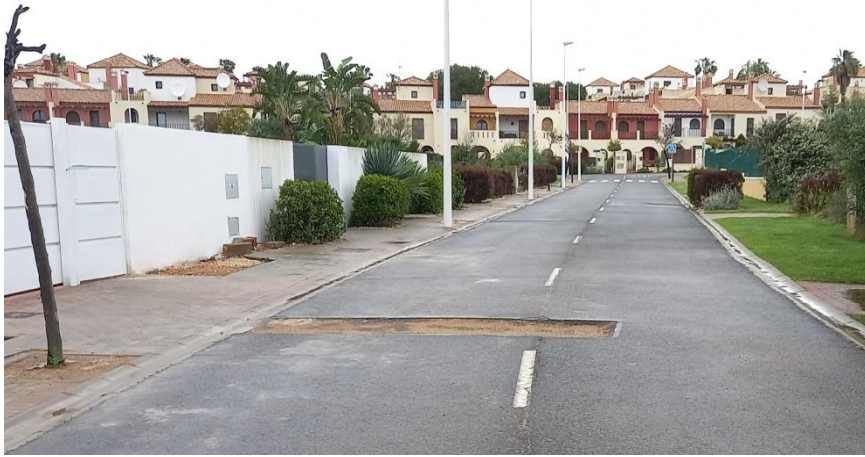
6.- Bartolomé de las Casas. Poste de señala cortada con peligro para caídas.
